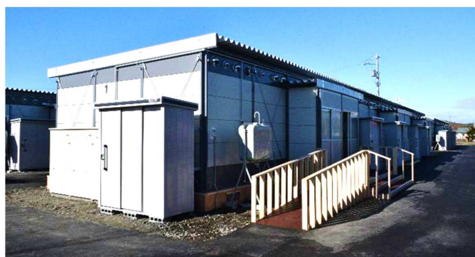
応急仮設住宅
