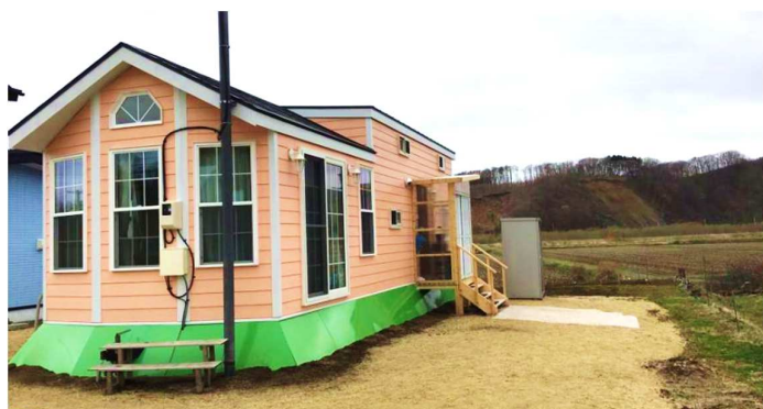
トレーラーハウス
